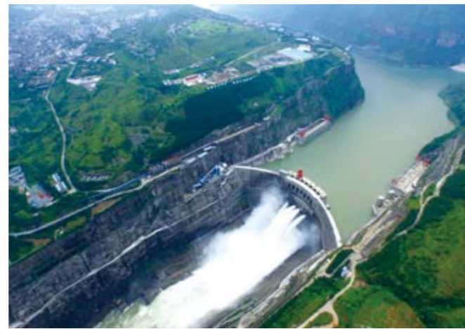
溪洛渡水电站全景
