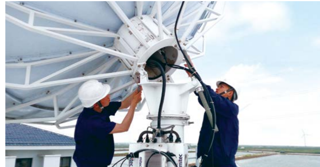
台风来临前通讯设备安全检查
