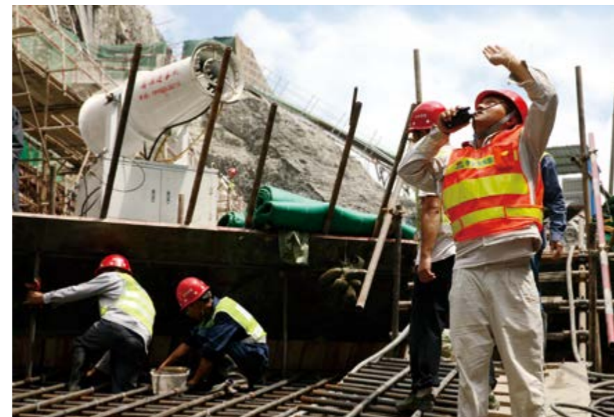
白鹤滩大坝建基面备仓施工
