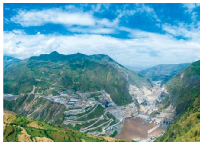
乌东德水电站全景
