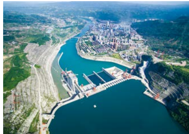
向家坝水电站全景
