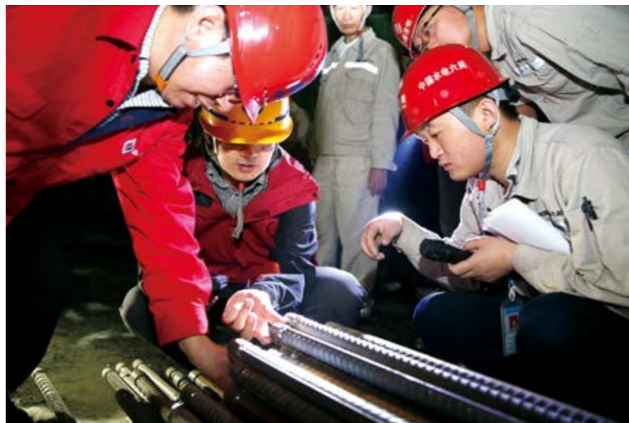
乌东德水电工程质量监督专家现场检查
