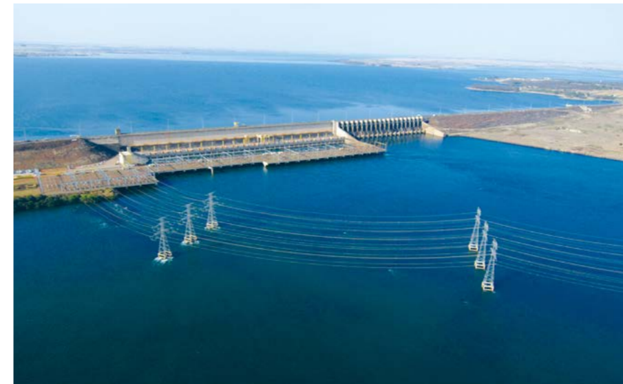
巴西伊利亚水电站
