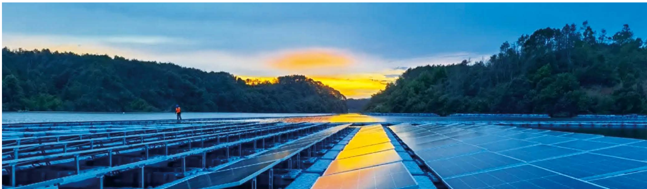
三峡能源在江西省万安县首个渔光互补项目现场
