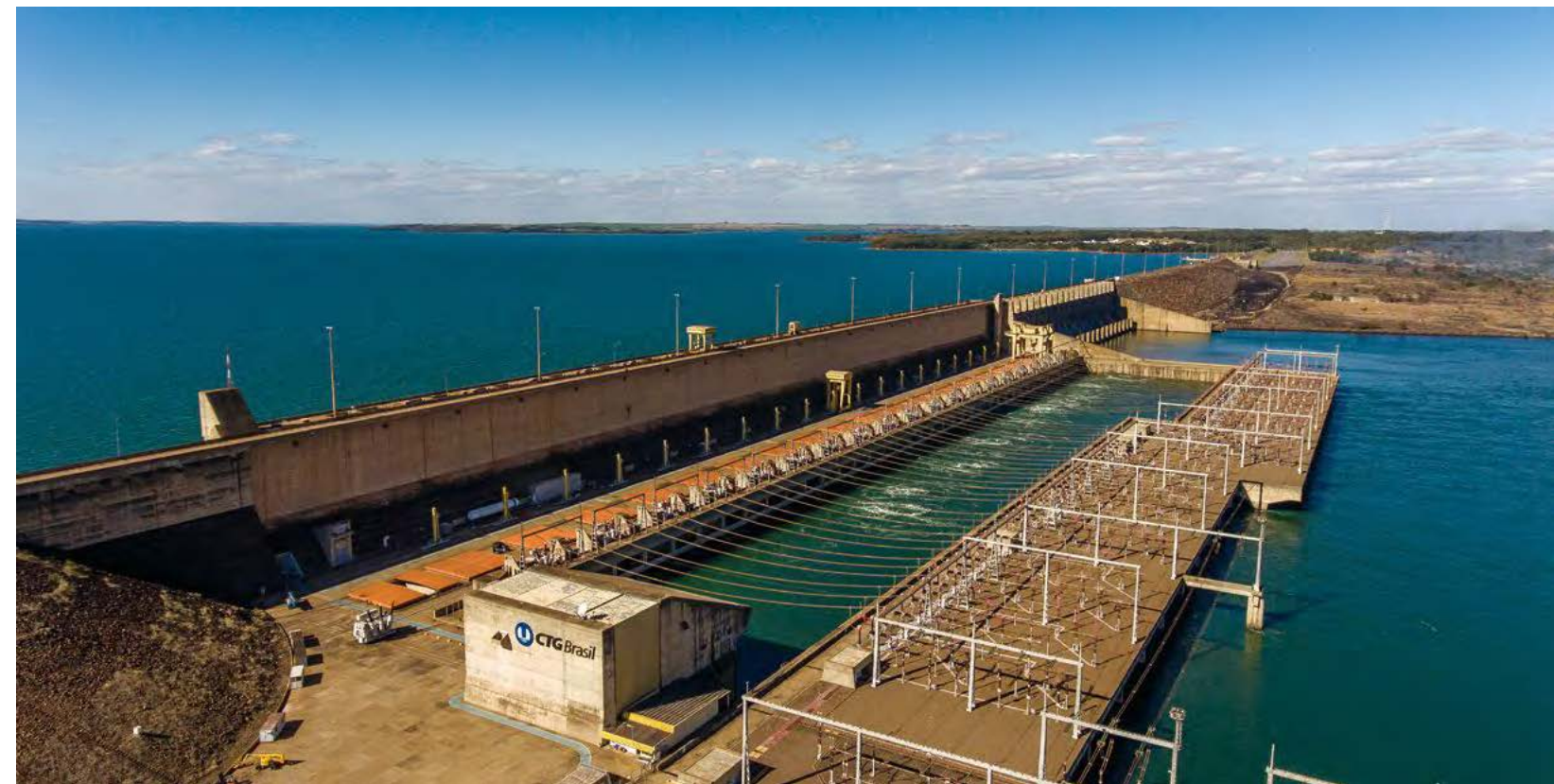
巴西伊利亚水电站
