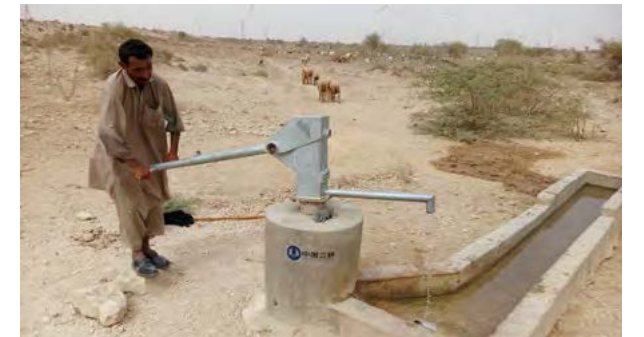
三峡南亚公司在当地改造供水设施
